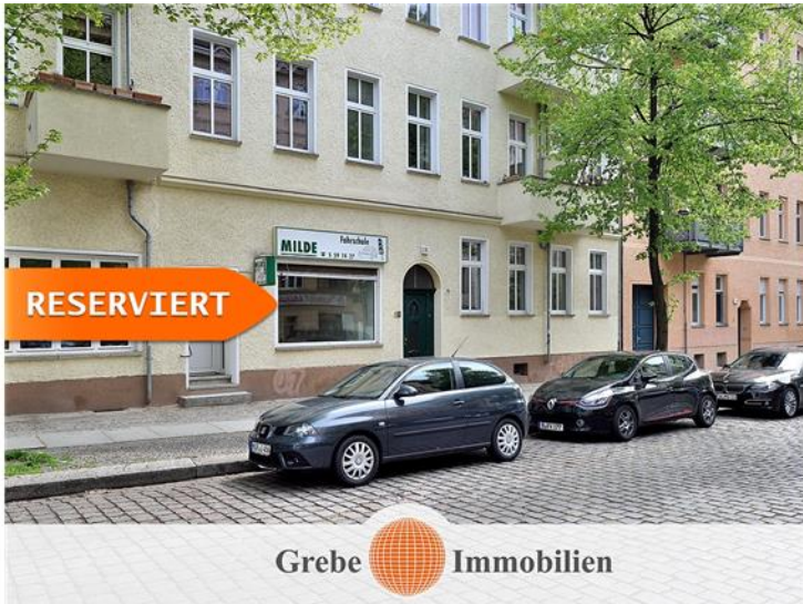
Blick von der Straße
